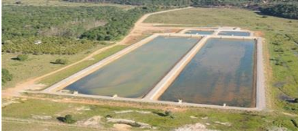
Figura 1. Lagoa de Estabilização. Fonte: CESAN, 2013.
